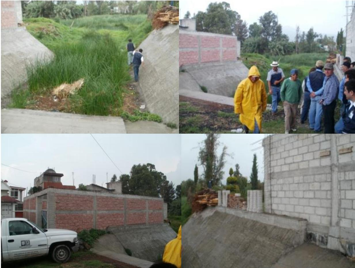
**Figura 15.-** Tramo 10 del recorrido donde se observa la presencia de vegetación acuática en la superficie del canal
