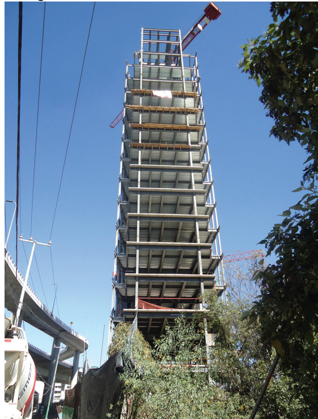
Fotografía 2. Construcción en área verde 'Presa Anzaldo'
