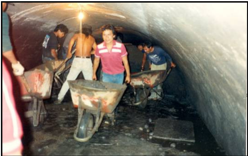
Figura 3.11 Trabajos de rehabilitación en el Interceptor del Poniente
