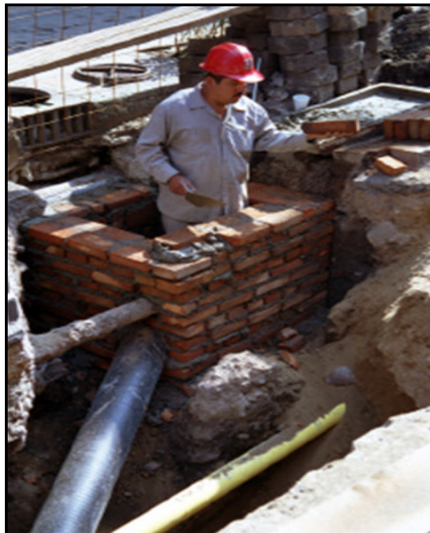
Figura 3.6 Trabajos de sectorización de la red de agua potable
