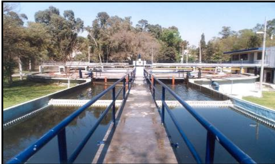
Figura 3.12 Planta de Tratamiento Chapultepec
