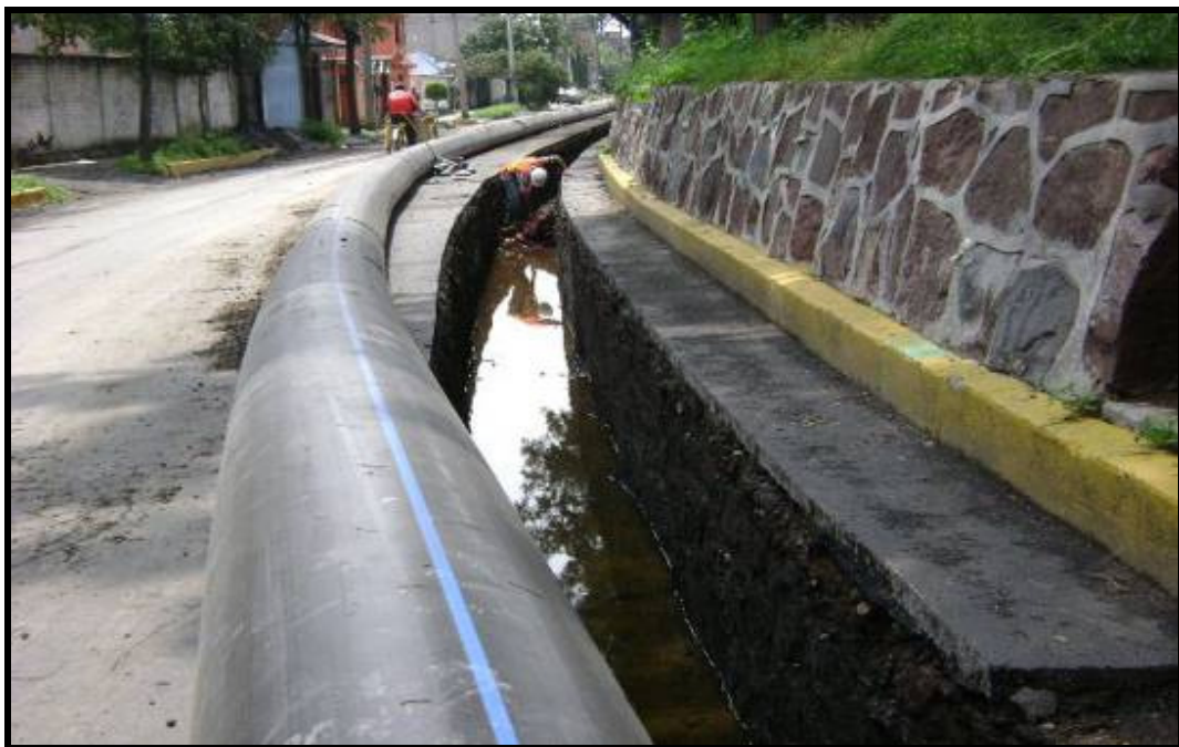
Figura 3.9 Construcción de colector para eliminar encharcamientos
