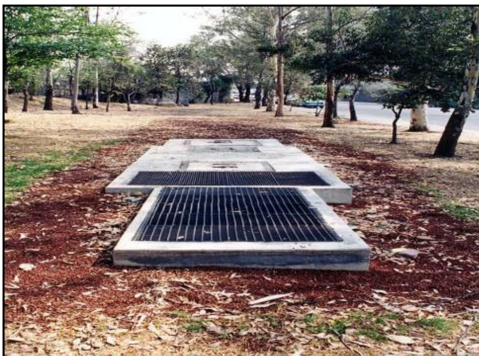
Figura 3.7 Estructura de captación de pozos de absorción
