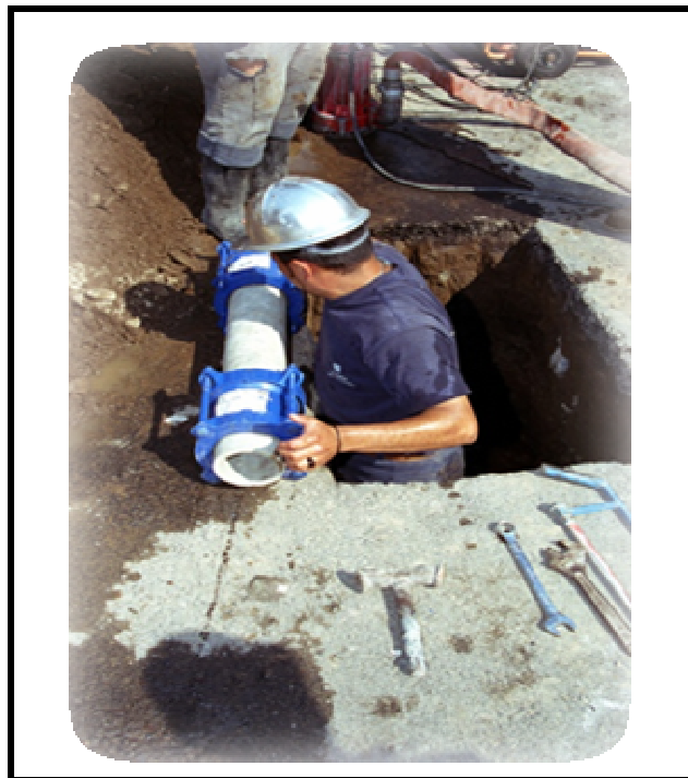
Figura 3.5 Sustitución de tubería en Colonias del Distrito Federal
